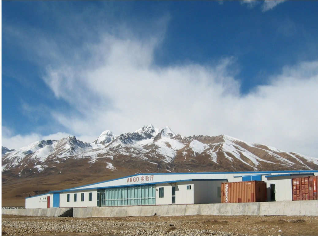
Vista esterna capannone progetto ARGO
